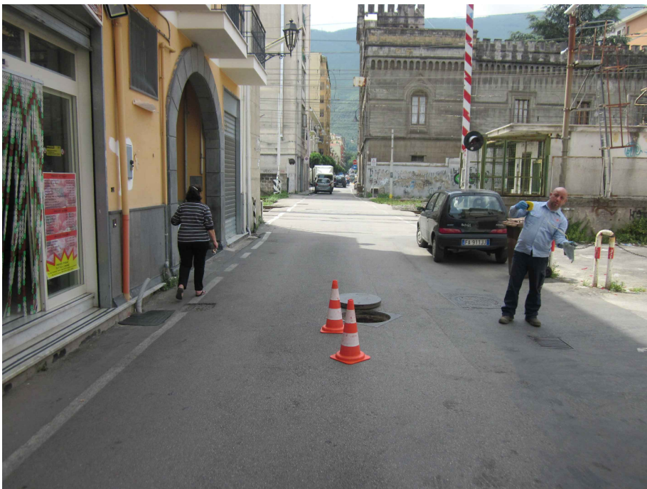
C33TLA05 Incrocio Via Dentice-Via Rea: n.1 scarichi acque reflue nel tratto Tombato del Torrente Solofrana
