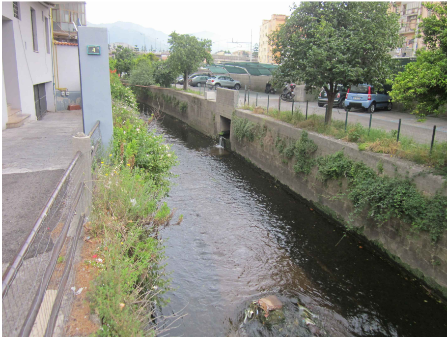
C33TLA20: Via Siniscalchi: n.1 scarico acque reflue nel tratto a giorno del Torrente Solofrana
