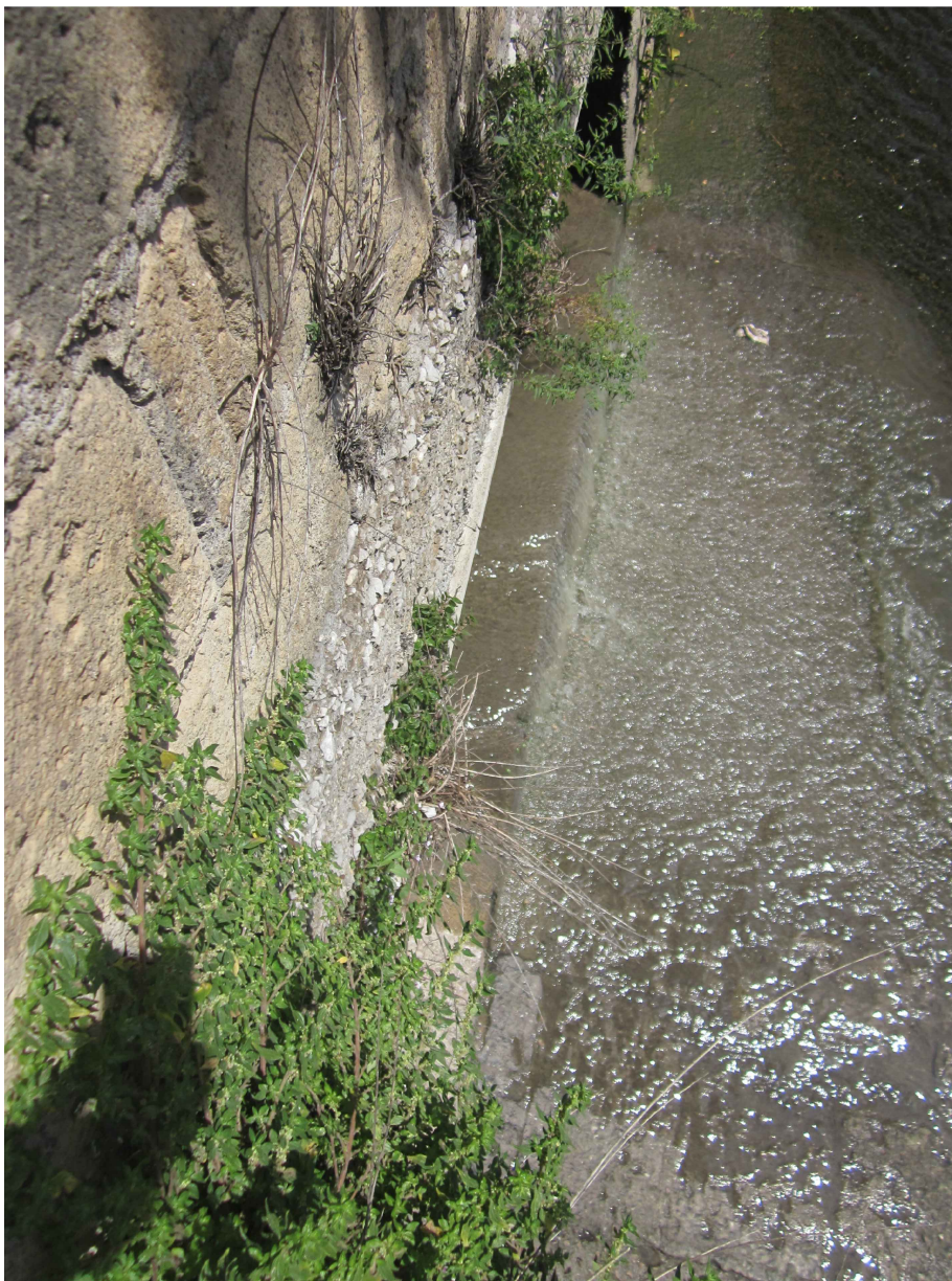
C33TLA03: Incrocio via Loira- via Pucci: n.1 scarico acque reflue nel tratto a giorno del Torrente Solofrana
