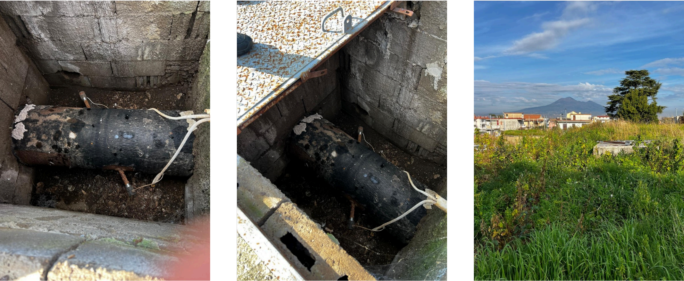
DN550 GRAGNANO IN USCITA DALLA CENTRALE E AREA MANUFATTO. SI NOTI L'ASSENZA DI GIUNTO DIELETTRICO
