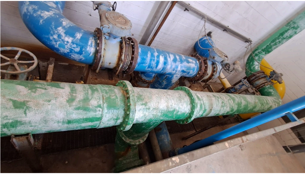
DN500 (AZZURRO) IN INGRESSO ALLA CAMERA DI MANOVRA. DN600 (VERDE) IN USCITA
