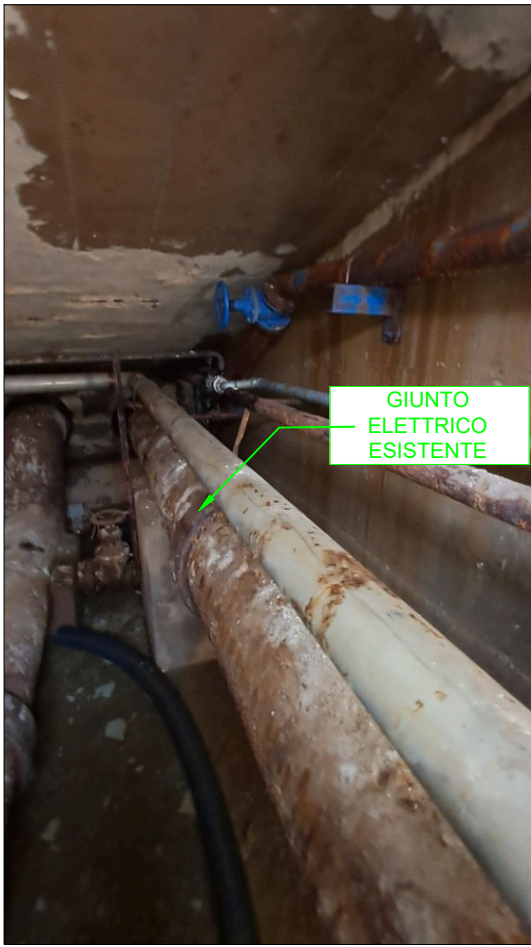
CONDOTTE IN INGRESSO E IN USCITA ALL'INTERNO DELLA CAMERA SOTTO IL PIAZZALE COME INDICATO IN ORTOFOTO
