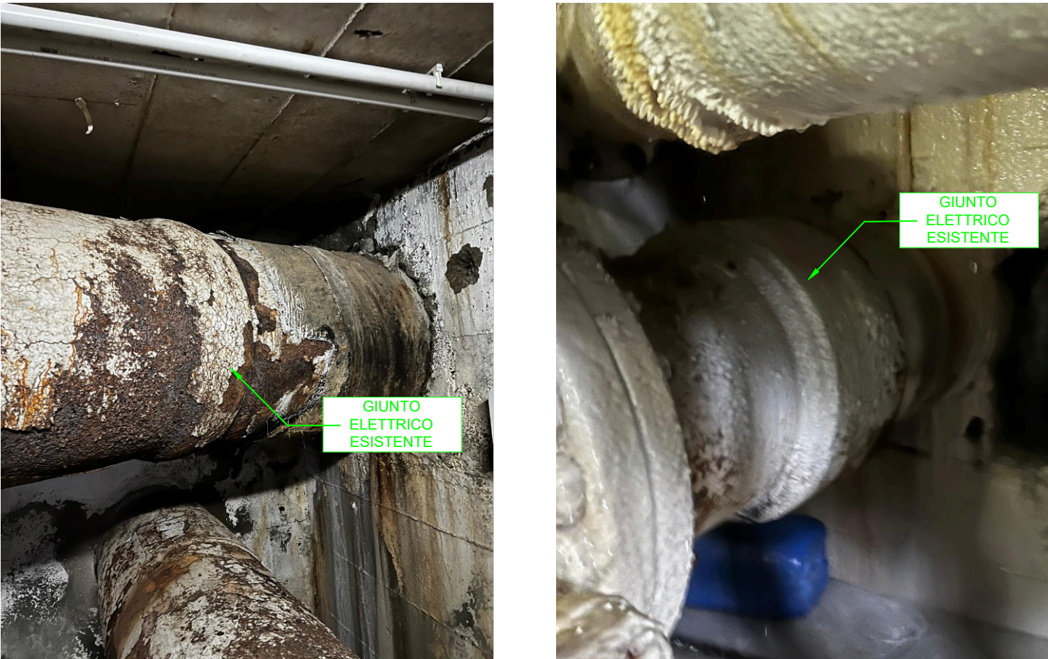
DN600 IN INGRESSO (A SINISTRA) E IN USCITA (A DESTRA) CON EVIDENZA DEI GIUNTI DIELETTRICI
